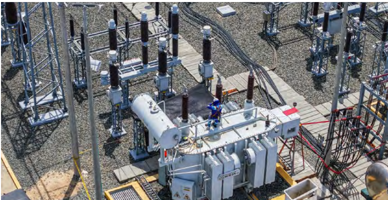
Air-e Intervenida suspenderá el servicio en circuitos Riohacha 2 y 6 por trabajos técnicos en la subestación.
