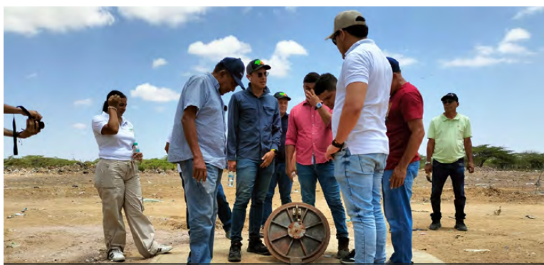
Alcaldía de Maicao verifica obras de alcantarillado sanitario para mejorar el saneamiento básico en cuatro barrios.
