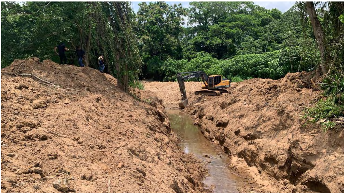
Gobernación ejecutó obras en Riohacha, Manaure y Dibulla para mitigar inundaciones y mejorar flujo de aguas en temporada de lluvias.
