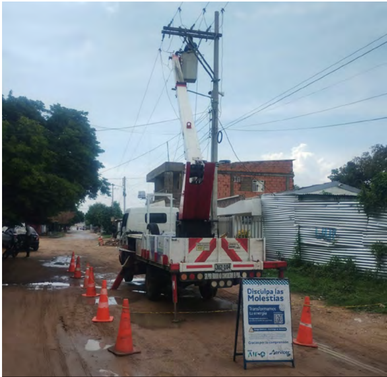
Un fuerte aguacero en Maicao causó inundaciones, daños materiales y cortes de energía, afectando al comercio y a numerosas familias del municipio.
