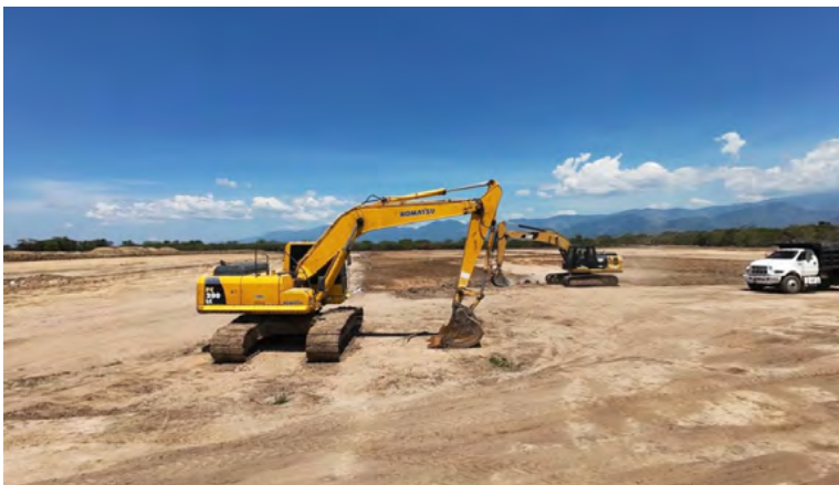
La Gobernación de La Guajira y Esepgua iniciaron la ampliación del STAR en San Juan del Cesar para mejorar saneamiento básico y calidad de vida.
