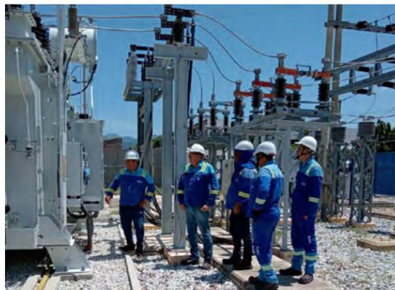
Juan, instalación de analizadores de redes en los puntos de transformación de barra a nivel de 110 kV en la Subestación San Juan, con un monitoreo mínimo de 7 días continuos, para constatar si las fluctuaciones 2 / 2 provienen de niveles de tensión superiores (110 kV) o de otros agentes del sistema regional o nacional.
