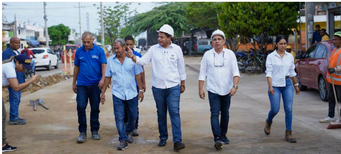
Gracias al control de la administración distrital, se habilitó un nuevo tramo vial en la Avenida Francisco el Hombre, mejorando el tráfico y la valorización en la zona de Riohacha.
