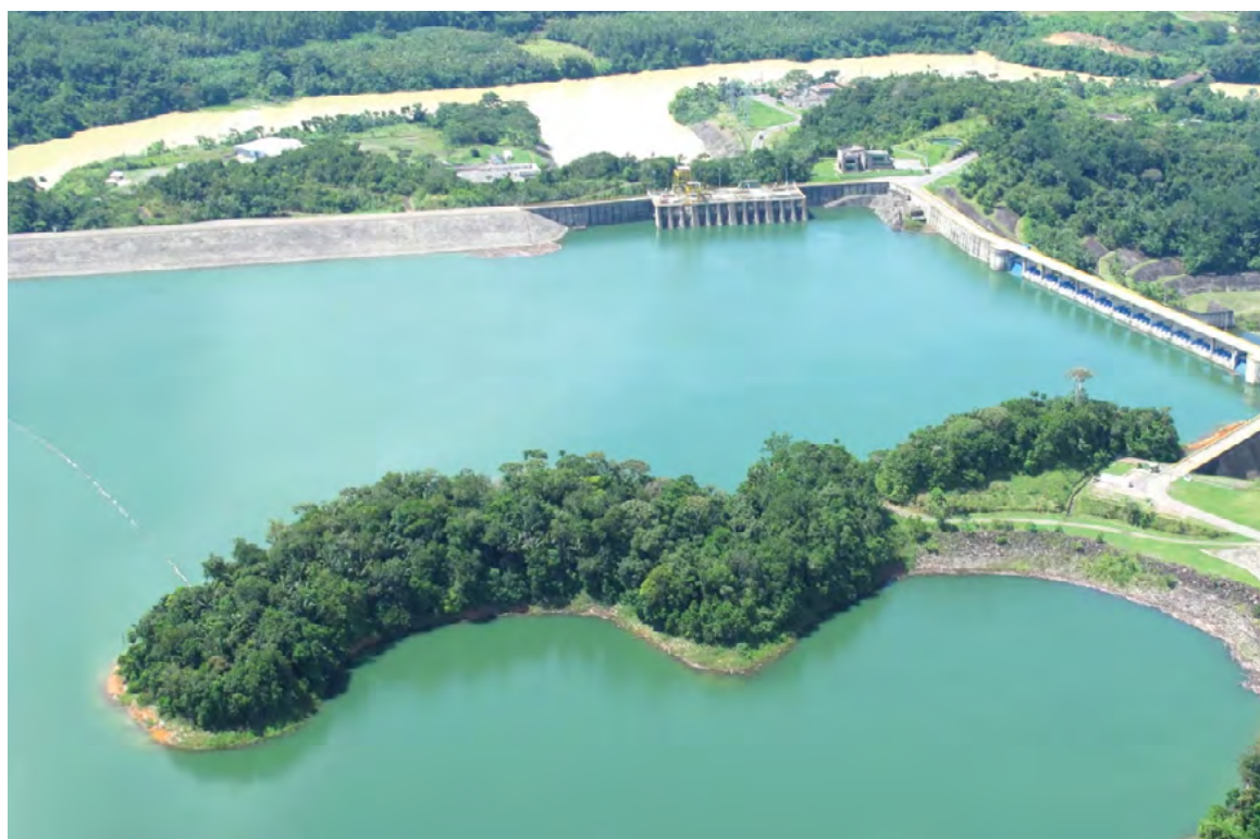
Hidroeléctrica de Urrá
