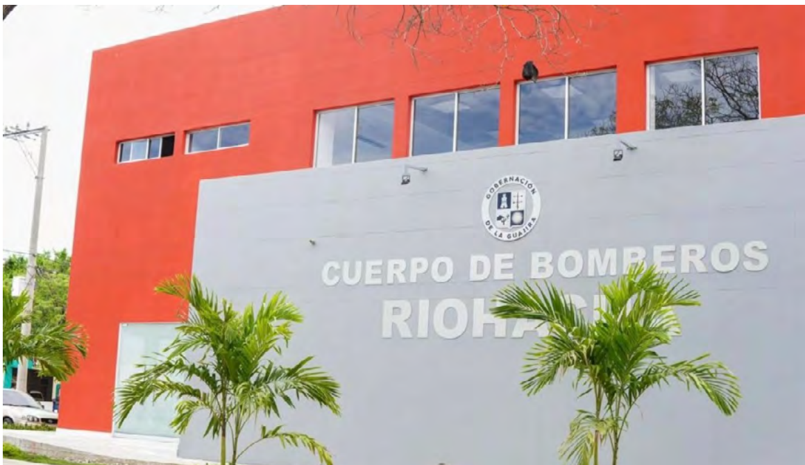
Nueva estación de Bomberos en la capital de La Guajira.
