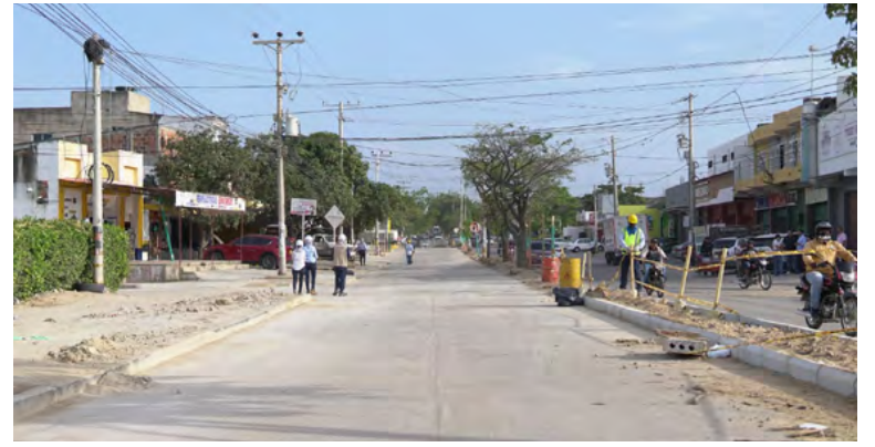
La obra forma parte del proyecto de mejoramiento urbanístico, que incluye optimización de redes y futuras intervenciones en andenes, bulevares e iluminación.
