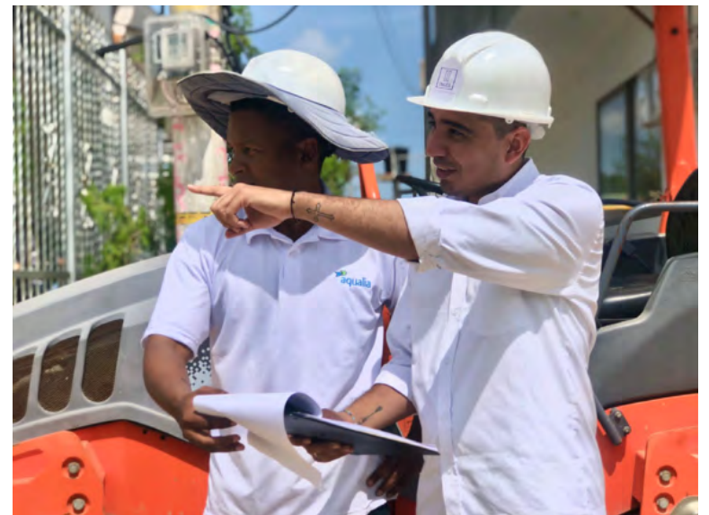
Puesta en marcha de la obra en la Calle 27B con carrera 16, barrio Las Tunas, en Riohacha
