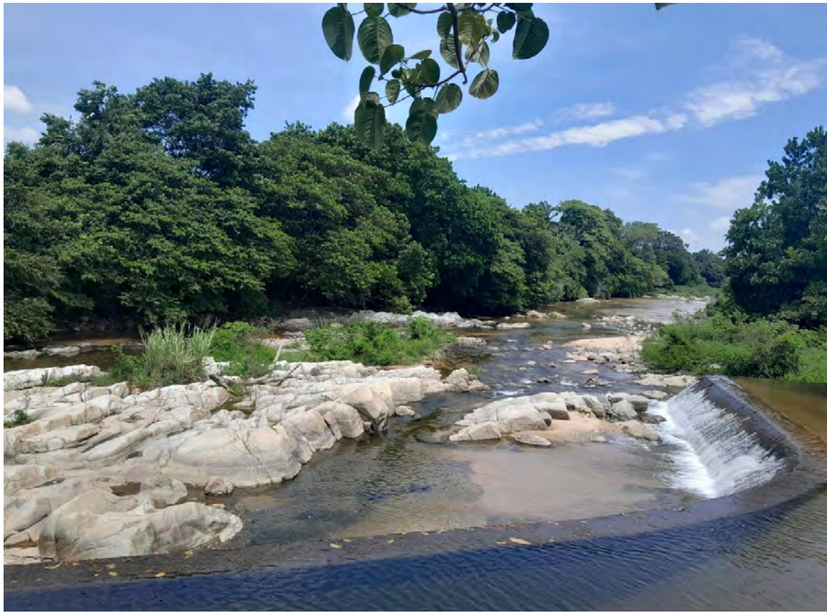
En ejecución proyecto que habilitará la planta de ósmosis La Luchita, con el propósito de aumentar la capacidad de abastecimiento de agua en Comuna 10.
