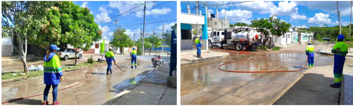
En una iniciativa conjunta entre la Alcaldía del Distrito de Riohacha, Aqualia e Interaseo, la comunidad del Barrio Arriba se unió para realizar una jornada de lavado y limpieza, contribuyendo al mejoramiento del entorno y promoviendo un ambiente más saludable.
