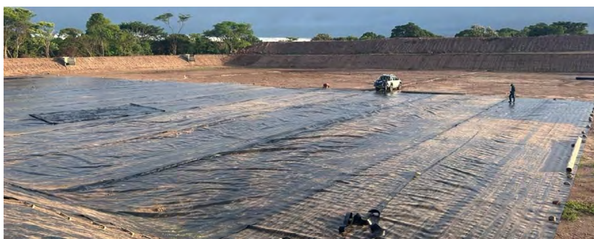
Esta inversión de más de 3 mil 800 millones de pesos mejorará las condiciones de la prestación del servicio de alcantarillado.
