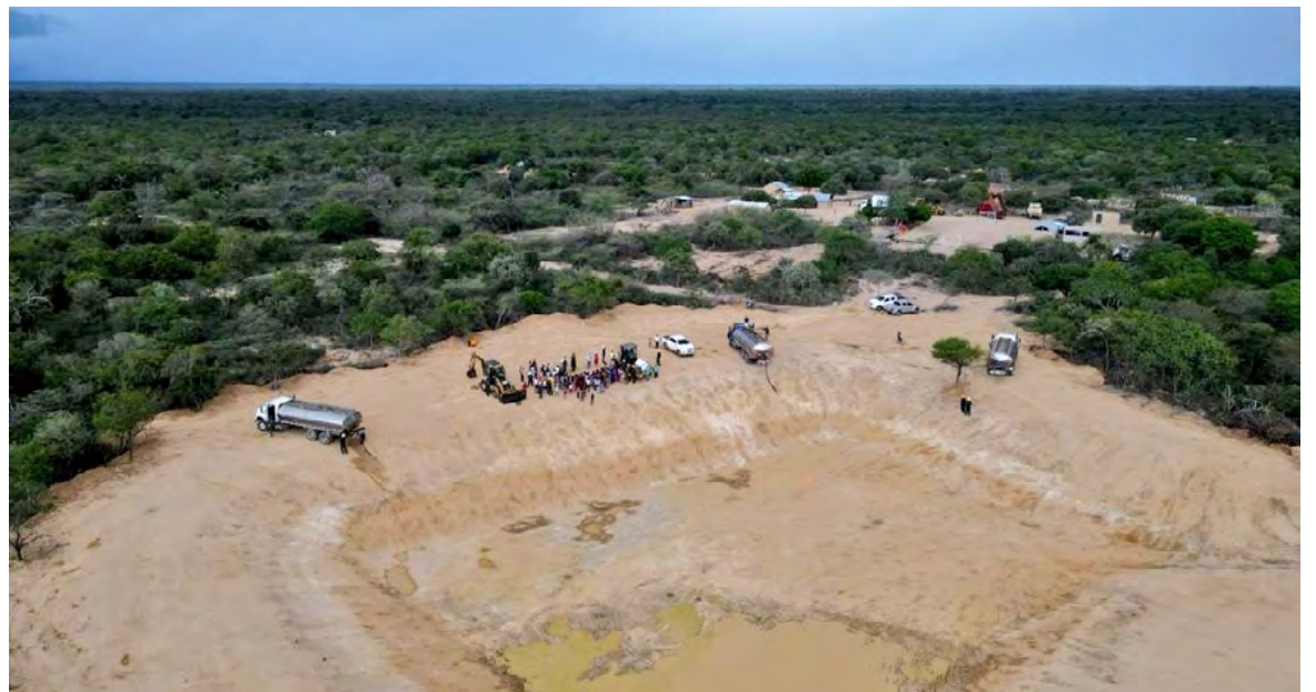
"Ya son más de mil los jagueyes construidos para recoger las aguas lluvias de octubre y noviembre", sostuvo el mandatario.
