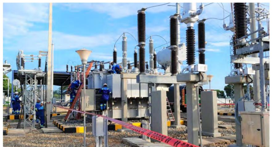
Personal de Alta Tensión de la empresa Air-e realizará mantenimiento general y pruebas predictivas en los transformadores de potencia de la subestación Riohacha que alimentan las líneas 529, Uribia - Manaure y línea 592, corregimientos de Riohacha.
