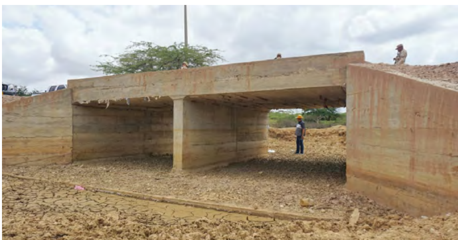
El mandatario de los maicaeros realizó recorridos por varios frentes de obras en compañía del equipo de la secretaría de Obras Públicas.
