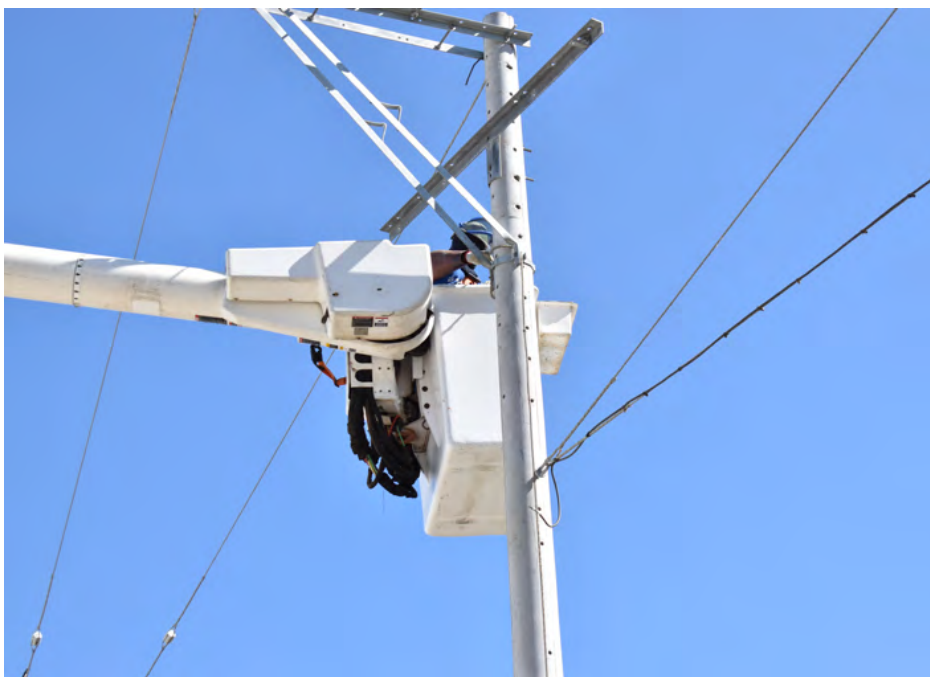
Adecuaciones técnicas por parte de la empresa Air-e.
