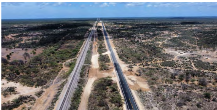
En la vía que de Uribia conduce al corregimiento de Poportín, se puso al servicio 1 kilómetro de vía pavimentada y se recorrieron los 10,6 kms restantes en donde se ejecutan obras.
