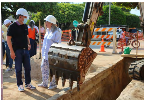
Instalación del primero tubo para el acueducto de Fonseca.
