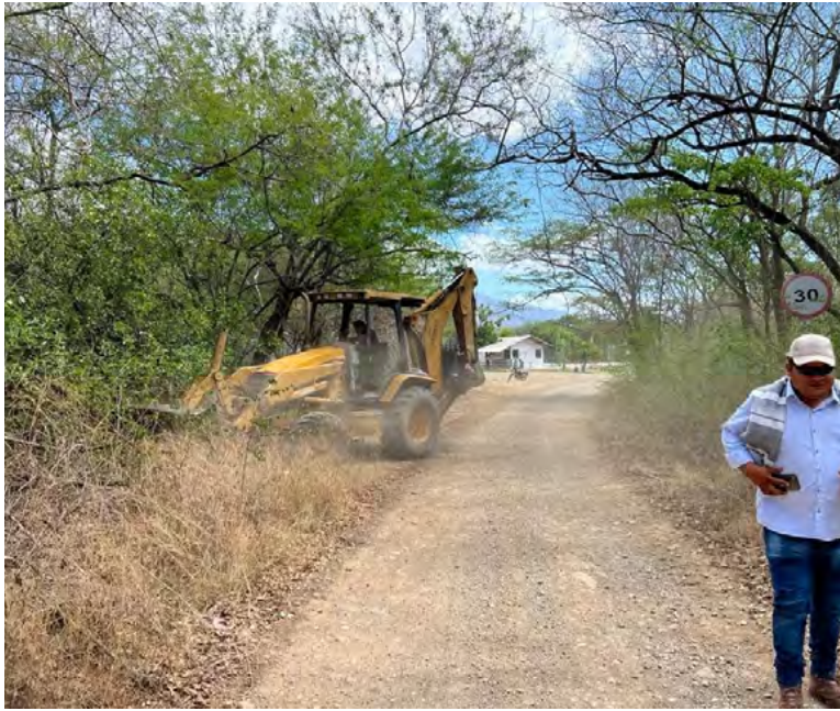
Inició el mejoramiento de la vía a Caracolí.
