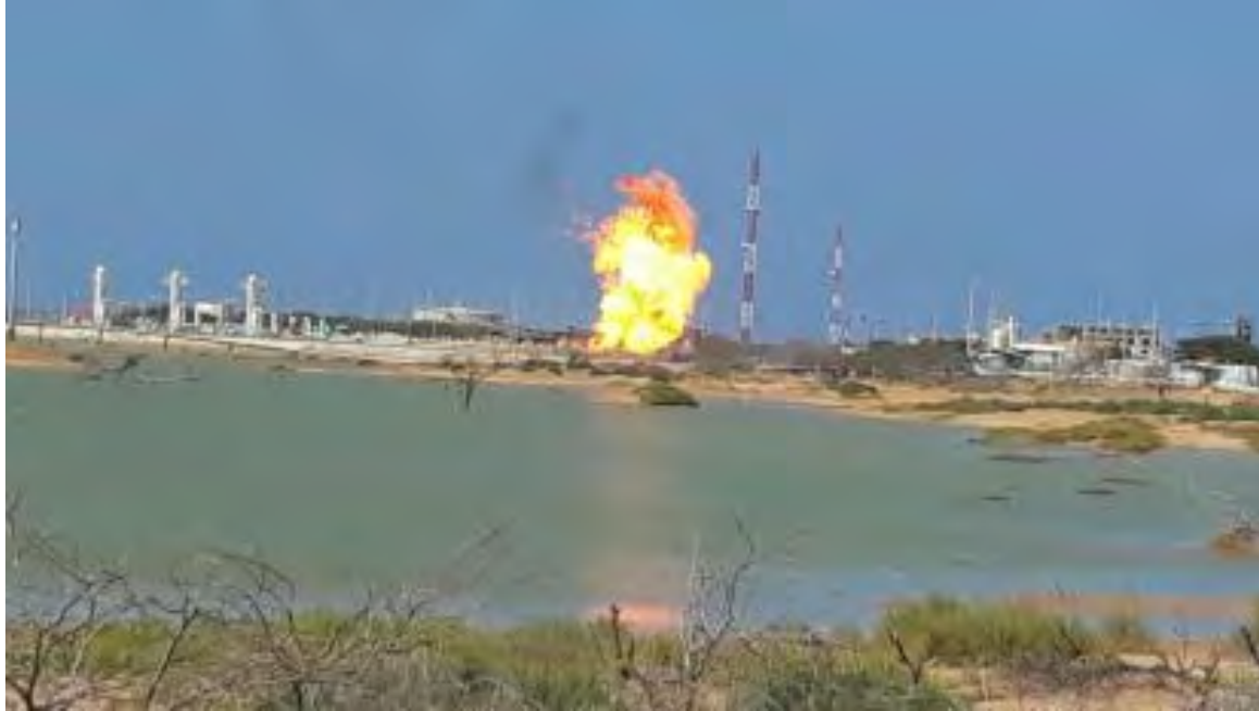
Instalaciones de la Estación Ballena donde se presentó el incendio.
