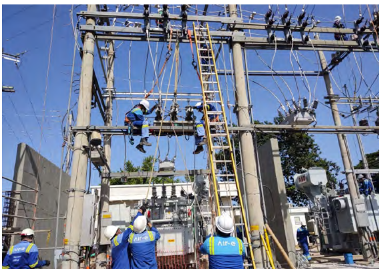
Trabajo en subestaciones.
