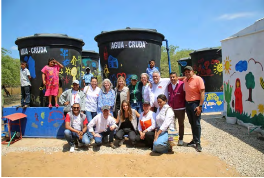
Rehabilitación de los pozos de Mapashira e Ishishon, en el municipio de Manaure, norte de La Guajira.
