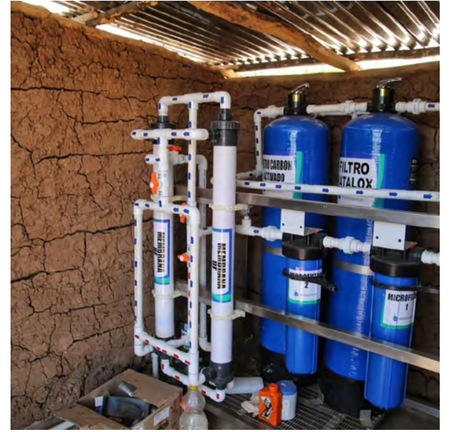
También se realizó un mantenimiento general de los sistemas eléctricos e hidráulicos.
