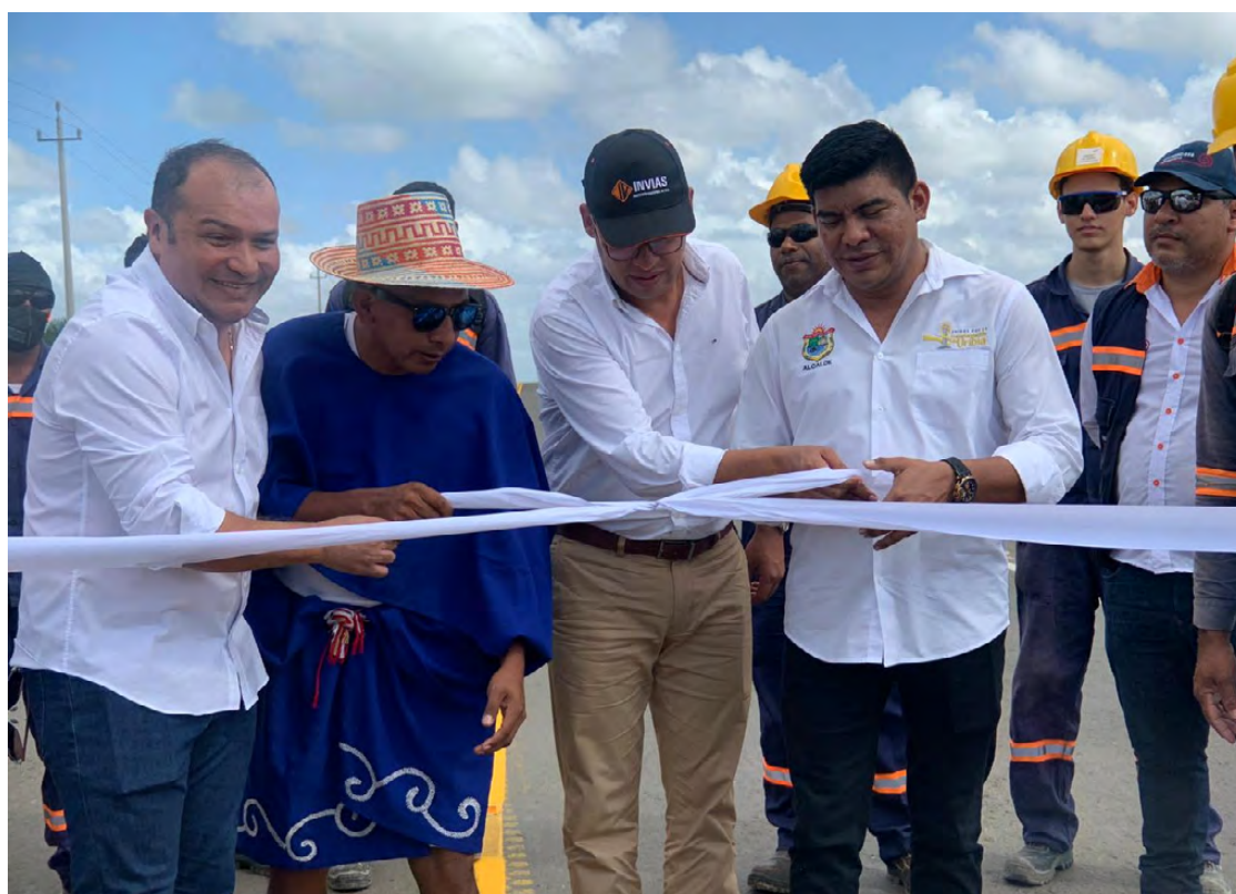
En la primera etapa culminaron los trabajos de construcción de 13 kilómetros entre el casco urbano de Uribia y el corregimiento de La Loma que ya están representando una mejora para la calidad de vida de las personas.
