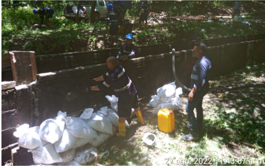
El trabajo puntual consistió en la reparación de unas fisuras o grietas, que estaban generando una fuga constante del agua.
