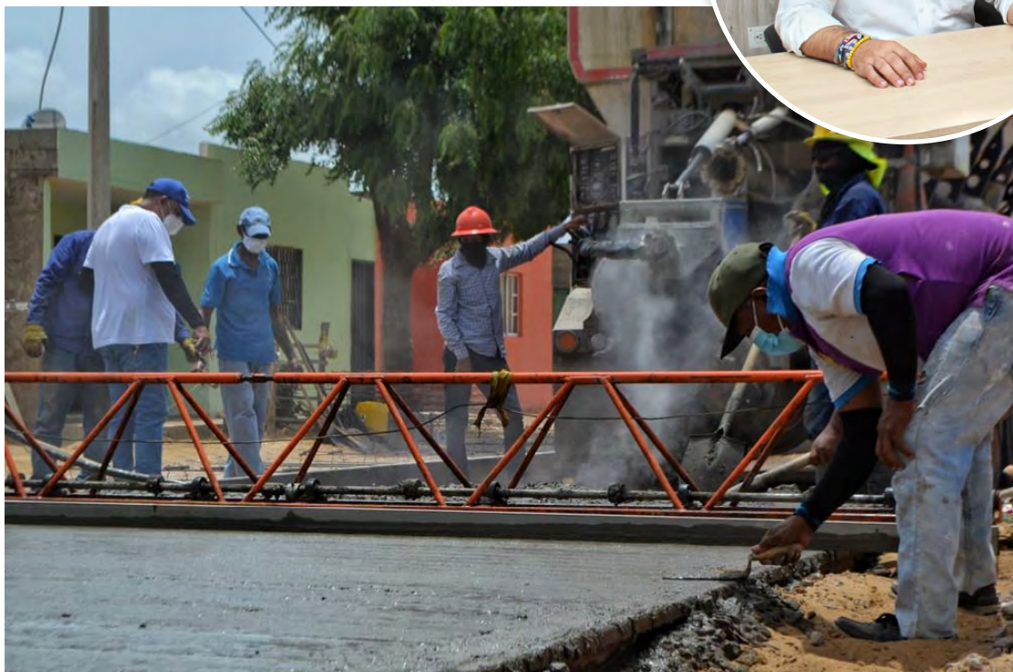
Las obras ya muestran avances en pavimento con fundido de placas de concreto rígido.
