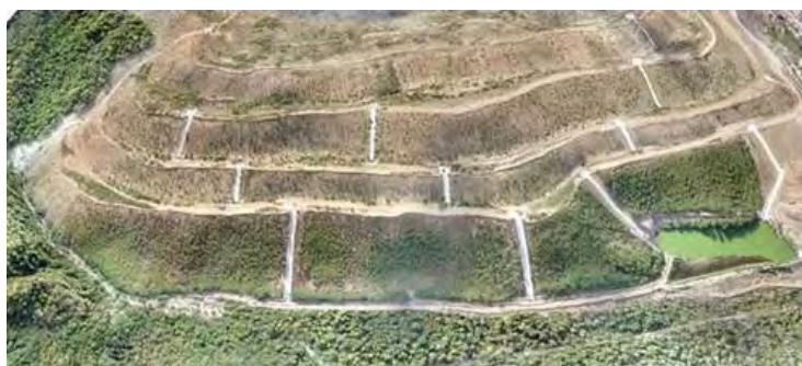
Cerrejón mejora el proceso de rehabilitación de tierras con unas innovadoras estructuras para el manejo de agua.
