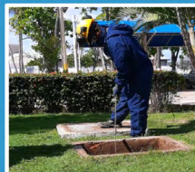
Mantenimiento de pozos sépticos
