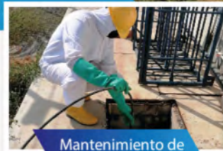
Mantenimiento de pozos sépticos
